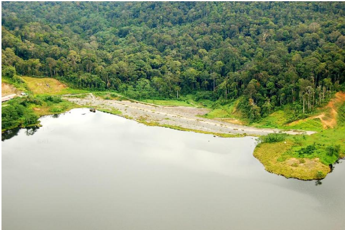
Gambar 15. Kondisi Dam Namuk yang cukup luas yang berpotensi untuk dimanfaatkan dalam pengelolaan kawasan (sumber: PT Kelian Equatorial Mining)
