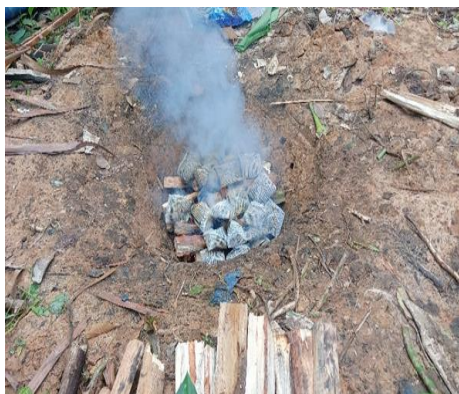
Gambar 3 Proses pembuatan biochar dengan metode konvensional
